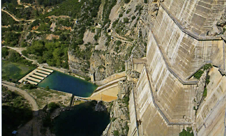
Le barrage de Canyelles dans la vallée de la Noguera. Un édifice impressionnant.
